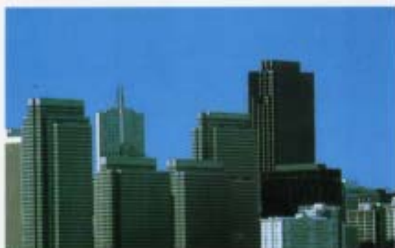
大樓空調 AIR CONDITIONING
